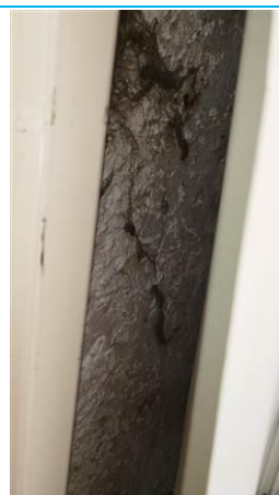
Matériaux : ZPSO-049 Prélèvement : P050 Description : joint cf Localisation : 1er étage - entrée 2 Résultat : Absence d'amiante
