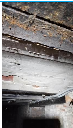
Matériaux : ZPSO-003 Prélèvement : P003 Description : Enduit à base de plâtre projeté Localisation : Sous-Sol - dgt Résultat : Absence d'amiante
