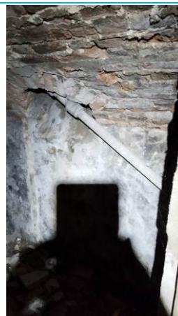
Matériaux : ZPSO-002 Prélèvement : P002 Description : Conduit en fibres-ciment Localisation : Sous-Sol - dgt Résultat : Présence d'amiante
