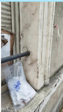
Matériaux : ZPSO-056 Prélèvement : P057 Description : Crépis extérieur ebrasements Localisation : Rez de chaussée - facade Résultat : Présence d'amiante
