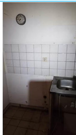
Matériaux : ZPSO-051 Prélèvement : P052 Description : Colle de faïence Localisation : 1er étage - séjour cuisine 1 Résultat : Absence d'amiante
