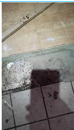
Matériaux : ZPSO-046 Prélèvement : P047 Description : Ragréage Localisation : 1er étage - séjour 1 Résultat : Absence d'amiante
