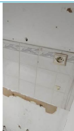
Matériaux : ZPSO-021 Prélèvement : P022 Description : Colle de faïence Localisation : 3ème étage - sdb 5 Résultat : Absence d'amiante
