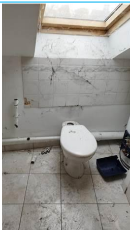
Matériaux : ZPSO-016 Prélèvement : P017 Description : Colle de plinthe Localisation : 3ème étage - sdb 6 Résultat : Absence d'amiante
