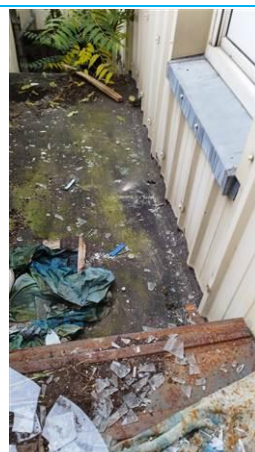
Matériaux : ZPSO-055 Prélèvement : P056 Description : Partie plane : revêtement bitumineux (bandes, lés...) Localisation : 1er étage - terrasson Résultat : Absence d'amiante
