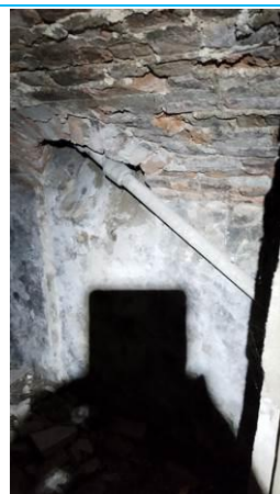
Matériaux : ZPSO-001 Prélèvement : P004 Description : Joint d'assemblage Localisation : Sous-Sol - cave 5 Résultat : Absence d'amiante
