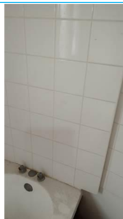
Matériaux : ZPSO-047 Prélèvement : P048 Description : Colle de faïence Localisation : 1er étage - sdb 2 Résultat : Absence d'amiante
