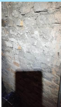
Matériaux : ZPSO-001 Prélèvement : P001 Description : Joint d'assemblage Localisation : Sous-Sol - dgt Résultat : Absence d'amiante
