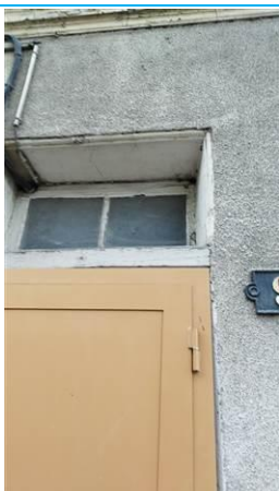
Matériaux : ZPSO-058 Prélèvement : P059 Description : Joint de mastic de vitrage (notamment châssis aluminium) Localisation : Rez de chaussée - hall Résultat : Absence d'amiante
