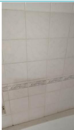
Matériaux : ZPSO-044 Prélèvement : P045 Description : Colle de faïence Localisation : 1er étage - cuisine 1 Résultat : Absence d'amiante
