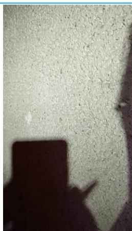
Matériaux : ZPSO-004 Prélèvement : P005 Description : Enduit à base de plâtre projeté Localisation : Rez de chaussée - hall Résultat : Absence d'amiante
