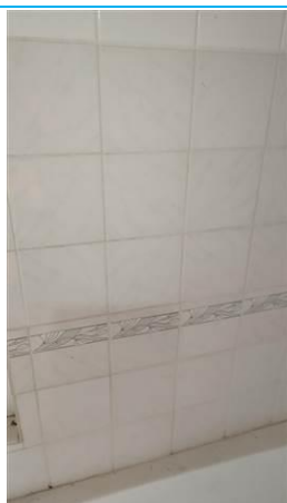
Matériaux : ZPSO-048 Prélèvement : P049 Description : Colle de faïence Localisation : 1er étage - sdb 2 Résultat : Absence d'amiante
