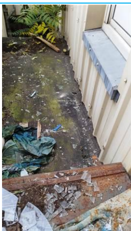
Matériaux : ZPSO-054 Prélèvement : P055 Description : Relevé : revêtement bitumineux (bandes, lés...) Localisation : 1er étage - terrasson Résultat : Présence d'amiante
