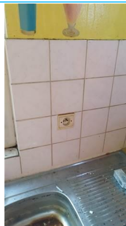
Matériaux : ZPSO-023 Prélèvement : P024 Description : Colle de faïence Localisation : 2ème étage - cuisine 2 Résultat : Absence d'amiante
