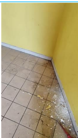
Matériaux : ZPSO-026 Prélèvement : P027 Description : Colle de plinthe Localisation : 2ème étage - cuisine 2 Résultat : Absence d'amiante
