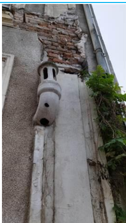
Matériaux : ZPSO-060 Prélèvement : P061 Description : Conduit de ventilation Localisation : Rez de chaussée - facade Résultat : Présence d'amiante
