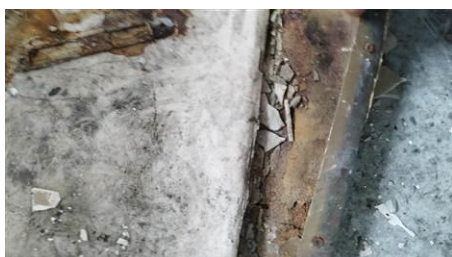
Matériaux : ZPSO-052 Prélèvement : P053 Description : Colle non bitumineuse Localisation : 1er étage - séjour cuisine 1 Résultat : Absence d'amiante
