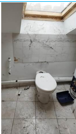
Matériaux : ZPSO-018 Prélèvement : P019 Description : Colle de faïence wc Localisation : 3ème étage - sdb 6 Résultat : Absence d'amiante
