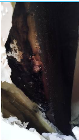
Matériaux : ZPSO-022 Prélèvement : P023 Description : bitumineux cheminée Localisation : 3ème étage - ch 7 Résultat : Absence d'amiante
