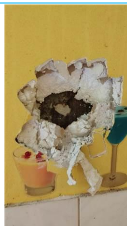
Matériaux : ZPSO-027 Prélèvement : P028 Description : Plot de colle fixant les cloisons au mur Localisation : 2ème étage - cuisine 2 Résultat : Absence d'amiante
